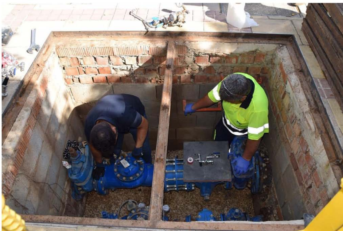
Técnicos instalan una válvula en una red de abastecimiento.
